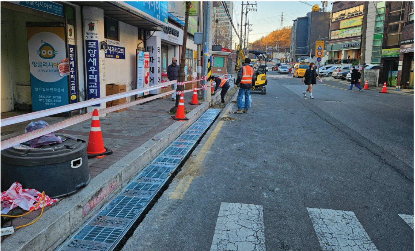
무소음 중하중 그레이팅 (배수로 일체형) 공사 시공현장사진
